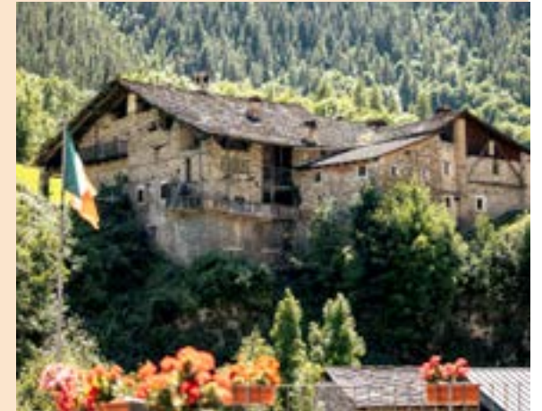
Ubac, vista dall'esterno
